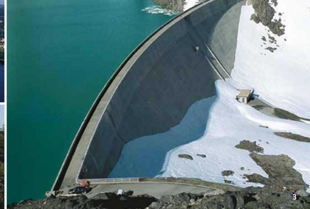
1 | Zwillingskraftwerk Augst-Wyhlen 2 | Kleinwasserkraftwerk Steinen 3 | Gries-Stausee im Kanton Wallis
