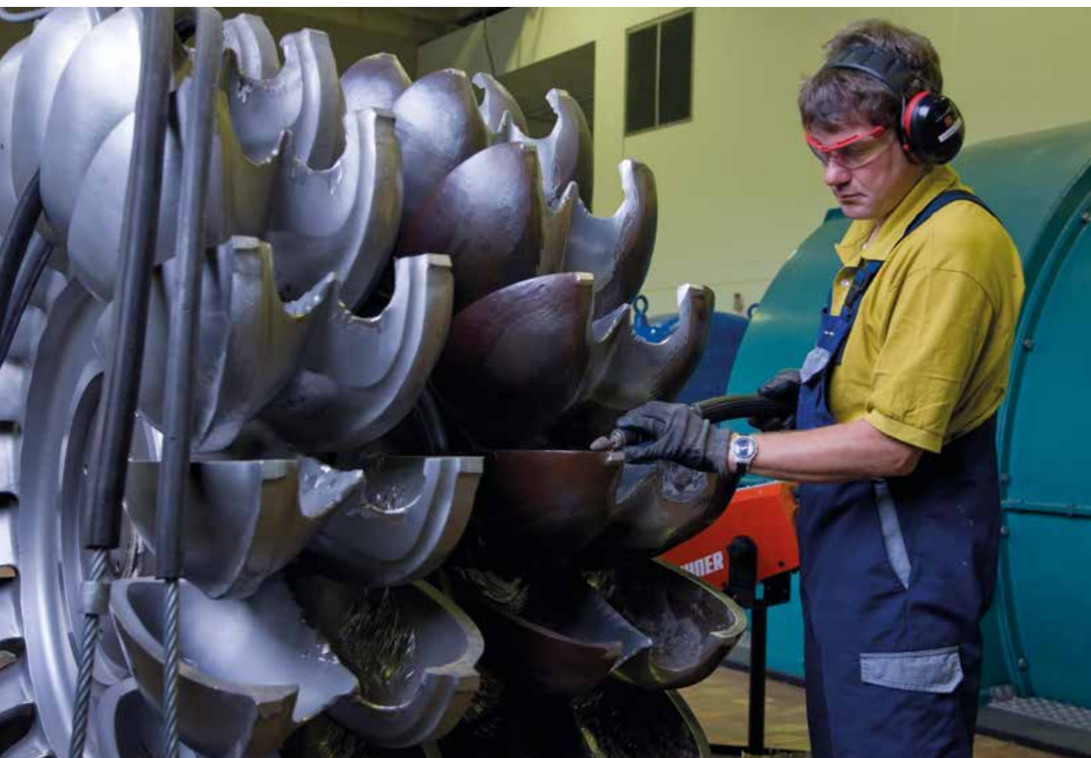
Regelmäßig überprüfen die Mitarbeiter im Kraftwerk Mörel das Laufrad jeder Pelton-Turbine auf Schäden.
